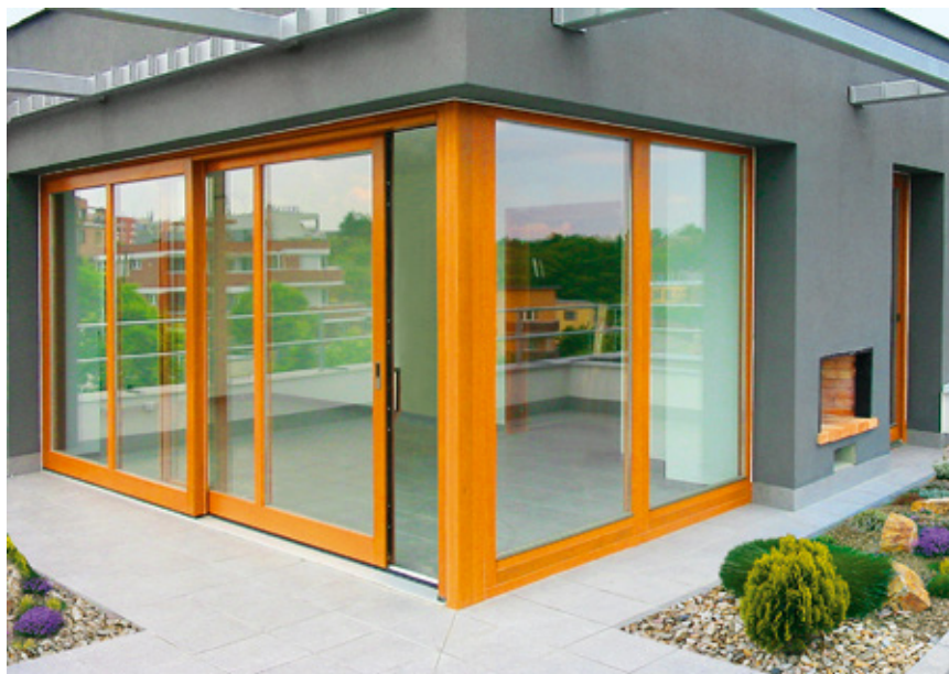
ukázka provedení rohu posuvné stěny
